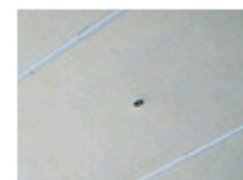
Industry Modus system med Connect Inline bärprofil och Absorbentskruv
